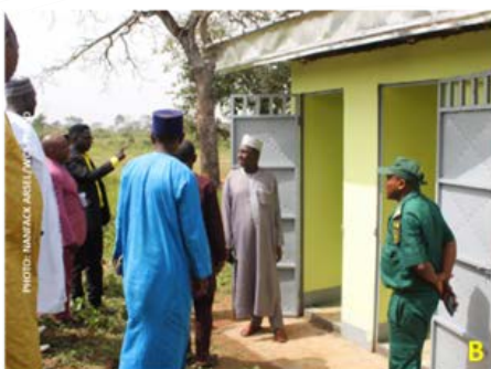
Bâtiment de 2 salles de classe construit à l'école d'Aviation
